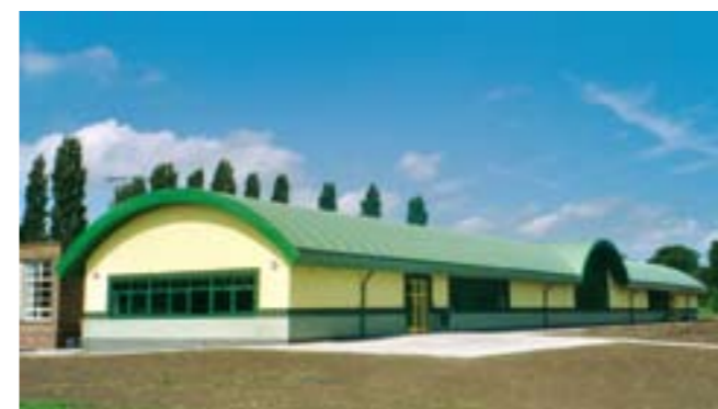
Рисунок 3.2.8 Вид мембранной кровли с имитацией фальца.
