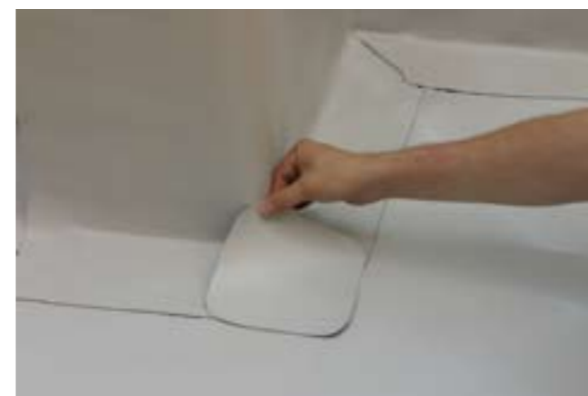
Применить заготовку детали усиления.
