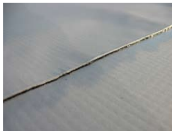
Рисунок 4.2.4 Визуальная проверка качества сварного шва.
