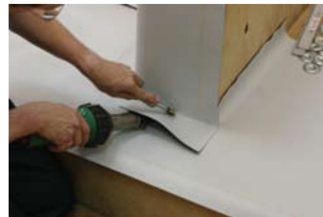
Приварить горизонтальную часть ручным феном.
