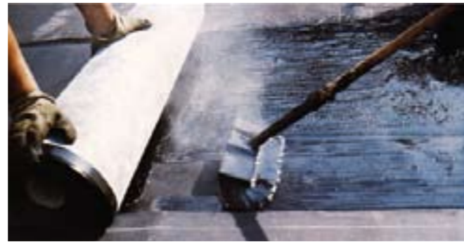
Рисунок 4.4.5 Приклейка ТПО-мембраны с подложкой на горячий битум.
