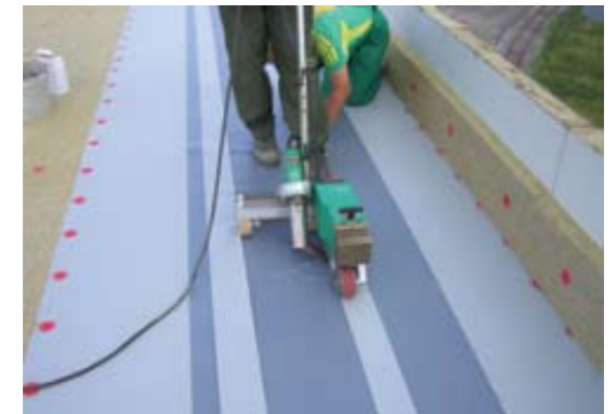
Рисунок 2.6.7 Приварка автоматом полосы.
