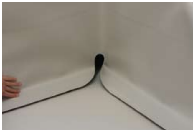
Во внутреннем углу формируется петля из материала.
