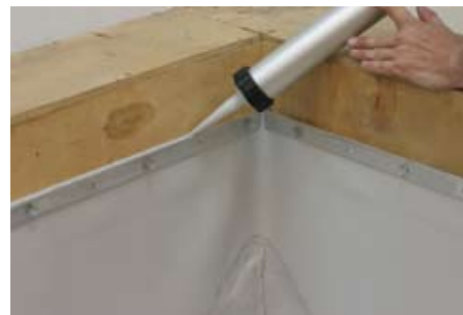
Заполнить поверхность отгиба рейки полиуретановым герметиком.
