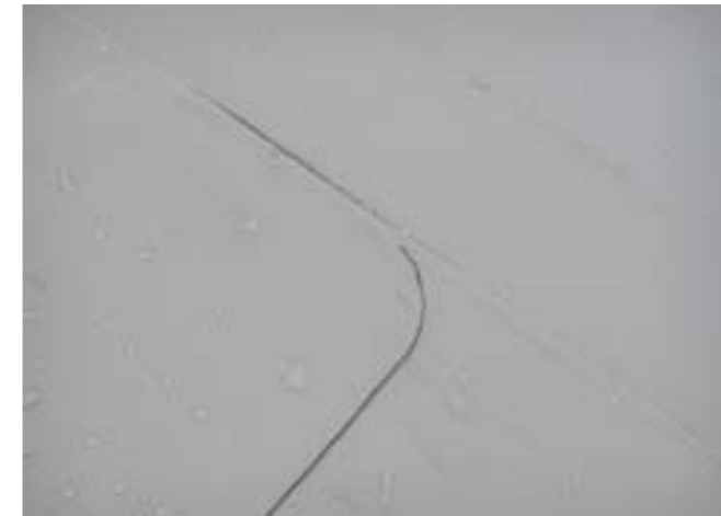
Рисунок 4.4.1 Скругление углов мембраны.
