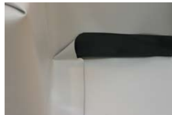
Ширина вырезанной полосы не менее 20мм.
