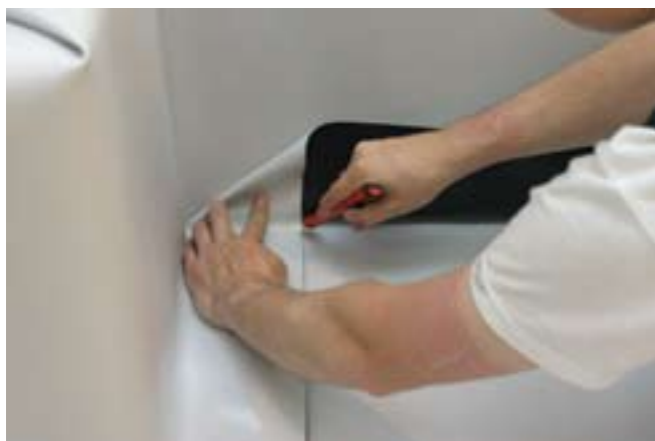
Размечается полоса шириной не менее 20 мм.
