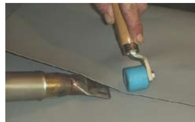
Рисунок 4.2.7 Автоматическая и ручная сварка мембран.
