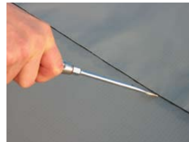
Рисунок 4.2.8 Проверка сварного шва при помощи отвертки.
