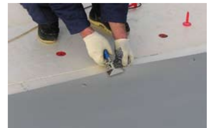
Рисунок 4.4.3 Натяжение мембраны.
