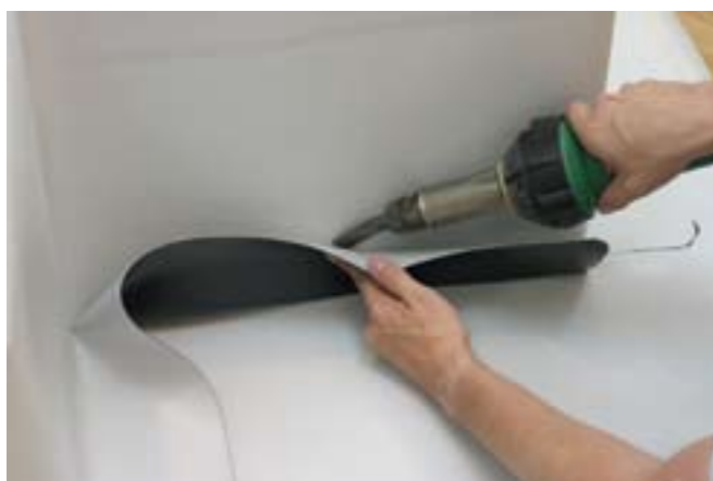
Прихватить материал к вертикальной поверхности как показано на рисунке.
