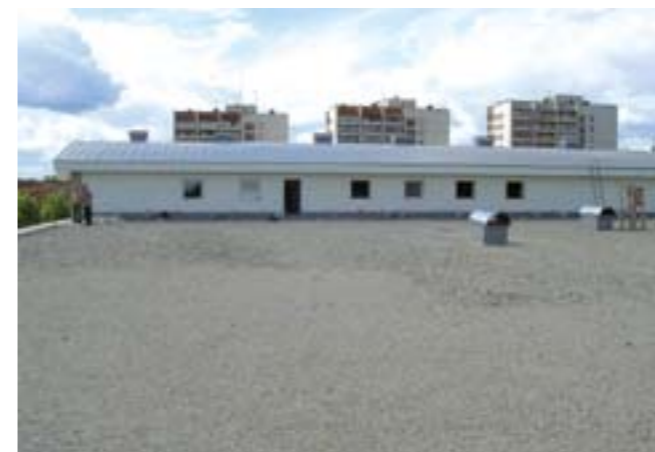
Рис. 1.1.2.1 Вид балластной кровли.
