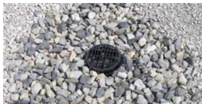
Рис. 1.1.2.3 Увеличение фракции балласта вокруг воронки.
