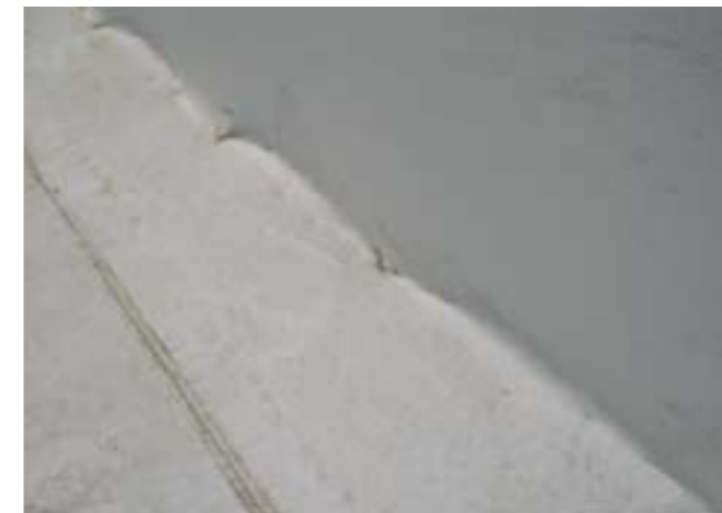
Рисунок 2.6.6 Возможное повреждение мембраны при классическом способе крепления к вертикальной поверхности.
