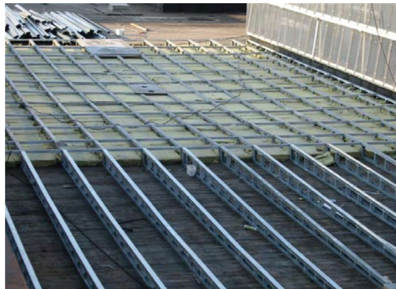
Рис. 2.3.3 Вариант устройства разуклонки.
