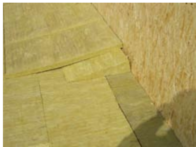
Рис. 2.3.1 Устройство контруклона клиновидным утеплителем.
