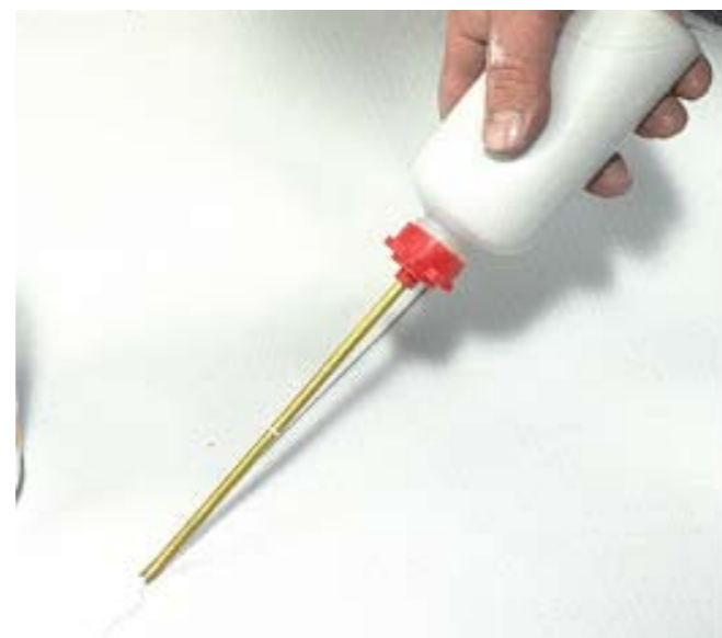
Рис. 2.4.2 Обработка стыка жидким ПВХ.
